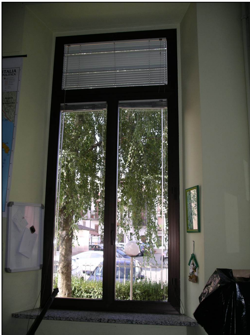
Figura 7: Finestra “tipo” esistente STATO DI FATTO
