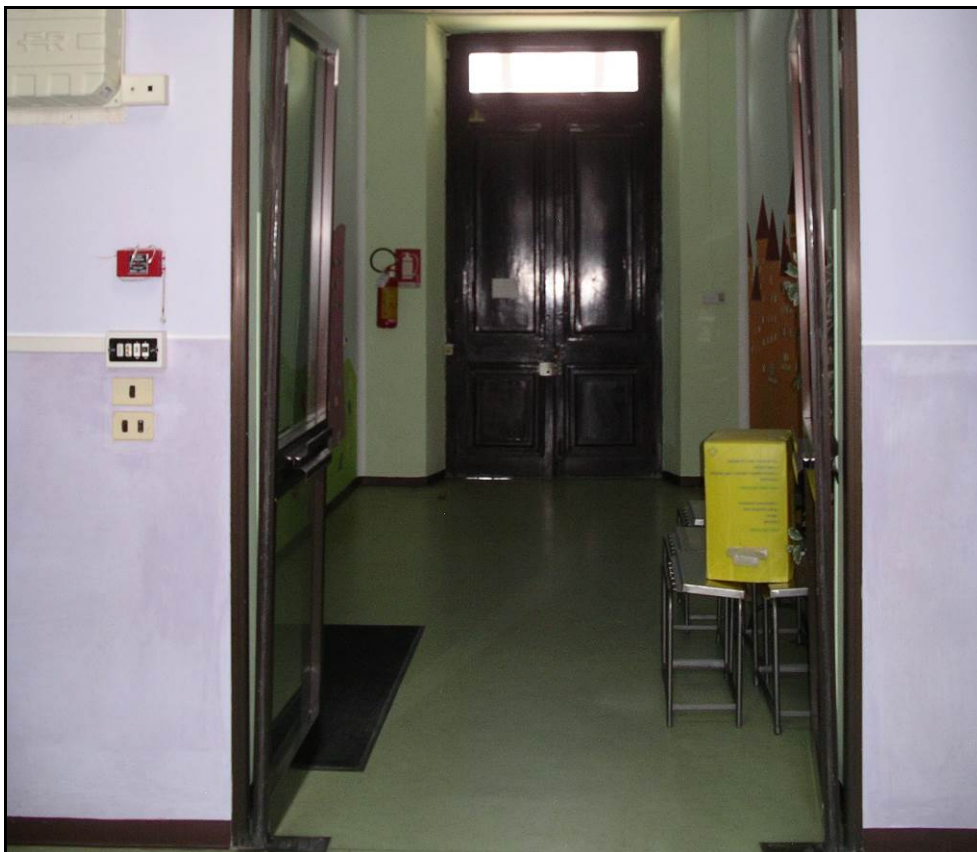
Figura 9: Porta di ingresso principale dell'edificio STATO DI FATTO
