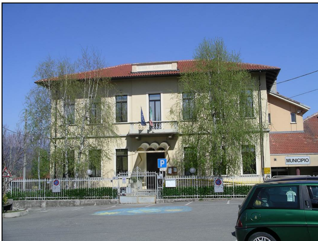
Figura 1: Sito di intervento
