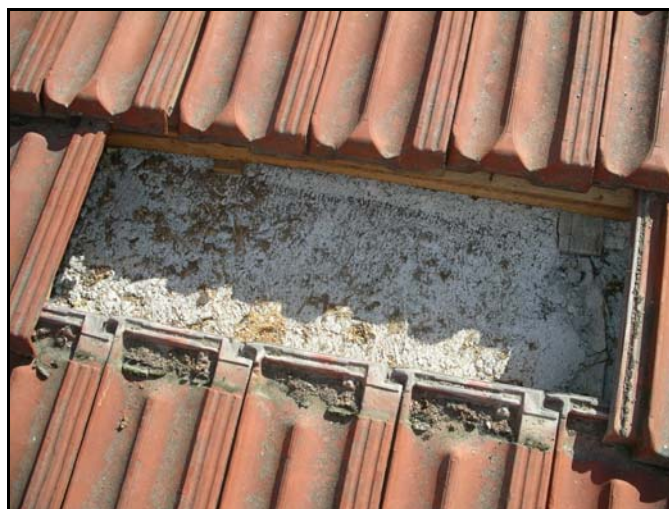
Figura 2: Copertura in laterocemento esistente
