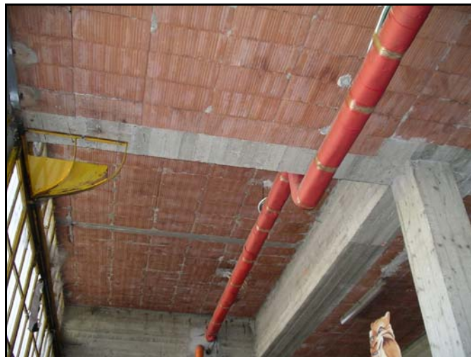
Figura 6: Solaio di confine verso il magazzino non riscaldato
