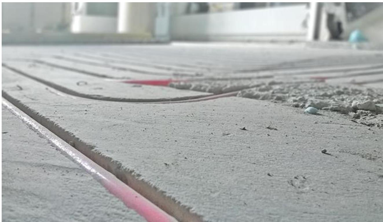
Per l'edificio in questione si considera un pavimento a bassa inerzia con sistema zeromax di passo pari a 20 cm al fine di non superare la resa massima pari a 100 W/mq
