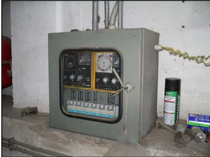
**Figura 3: Sistema di regolazione – Centralina programmabile**
