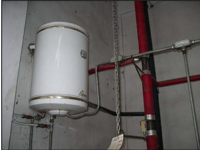
**Figura 5: Impianto di produzione ACS – Boiler elettrico ad accumulo**
