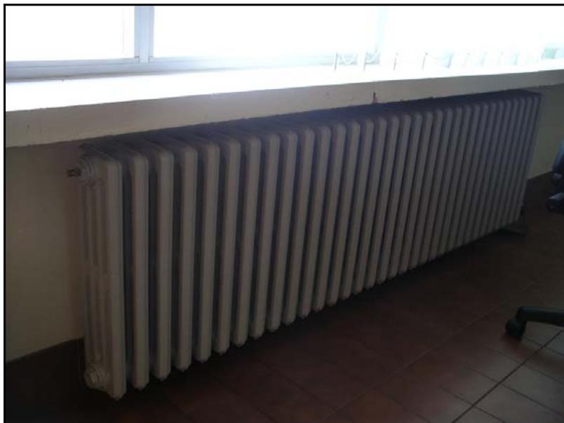
**Figura 4: Sistema di emissione – Radiatore in ghisa**
