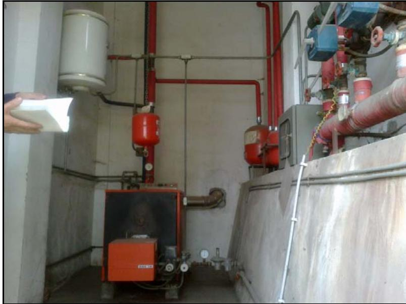
**Figura 1: Sistema di generazione – Caldaia a gas metano**
